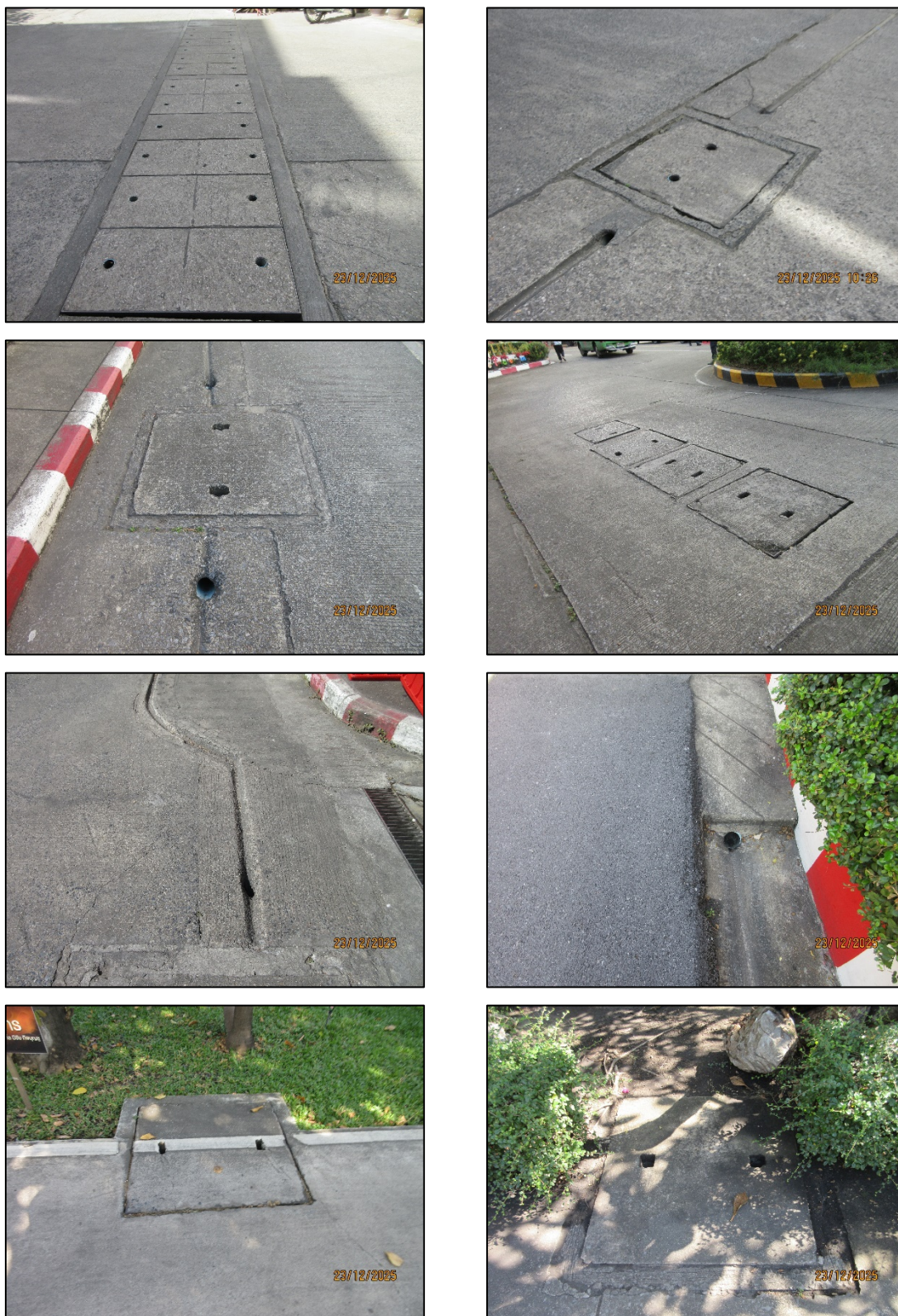
รูปที่ 1-7 ระบบระบายน้ำรอบโครงการ
